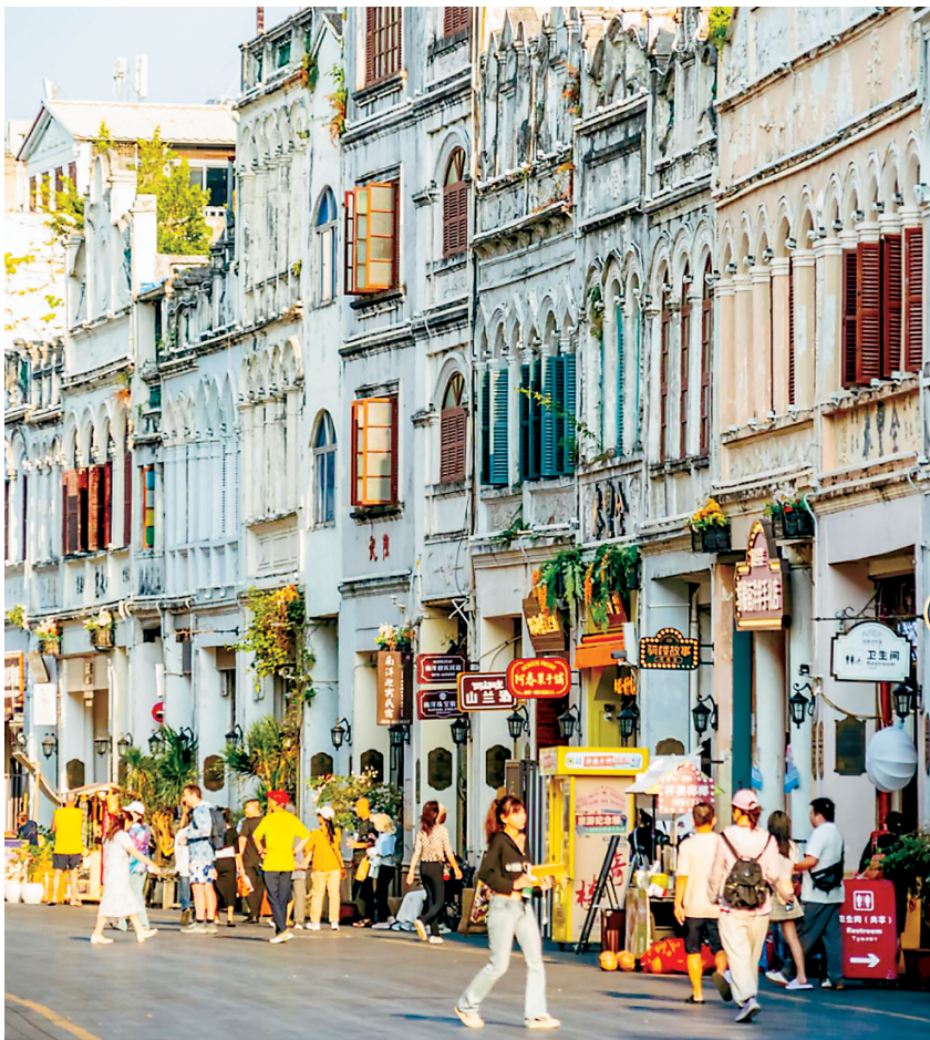
海口骑楼建筑历史文化街区整旧如旧。
