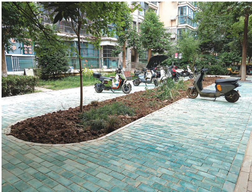
铺设完成的透水砖道路。
