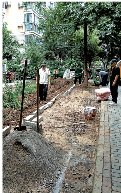
工人师傅铺设透水砖。
