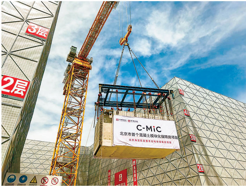
北京定慧寺北地块保租房项目智能建造技术吊装现场。 新华社发
