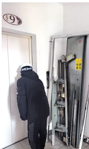
工作人员修补电梯边沿缝隙。
