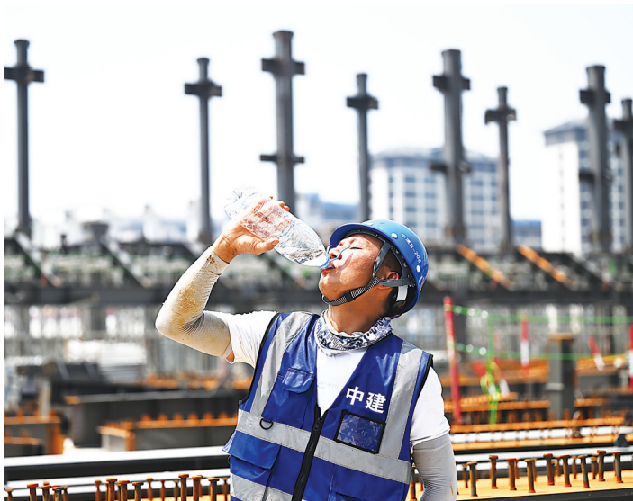
7月2日,中建二局工人在北京科技大学雄安校区建设现场喝水解暑。
