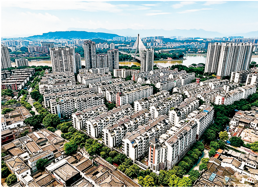
福州市大力实施旧城改造,图为福州市台江区的苍霞新城。
