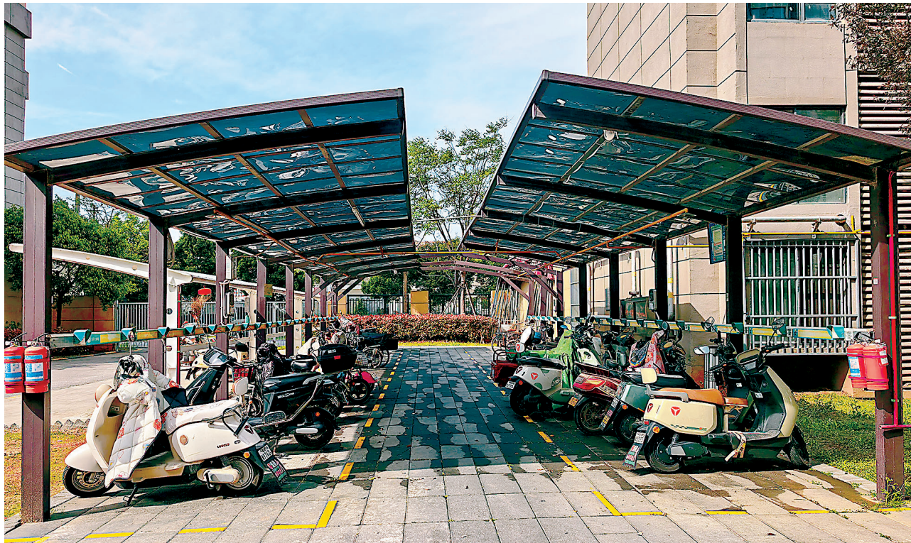
新修建的电动车棚。
