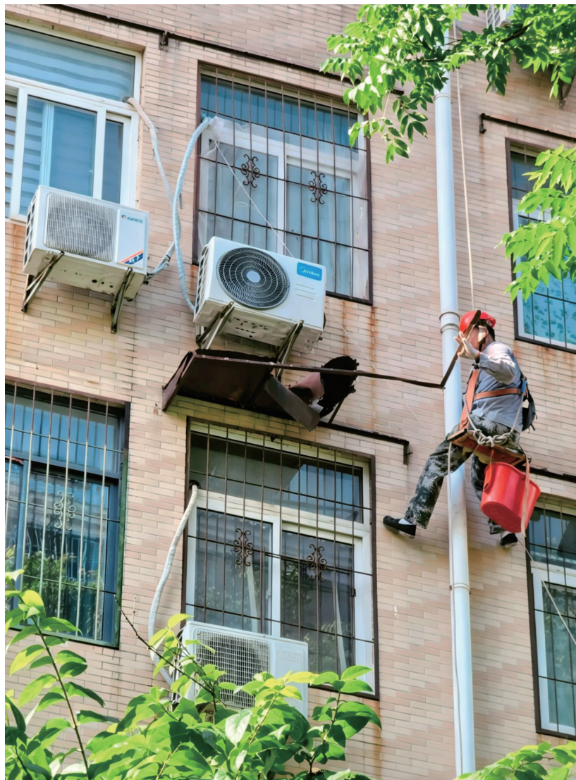
工作人员拆除破旧遮阳棚。
