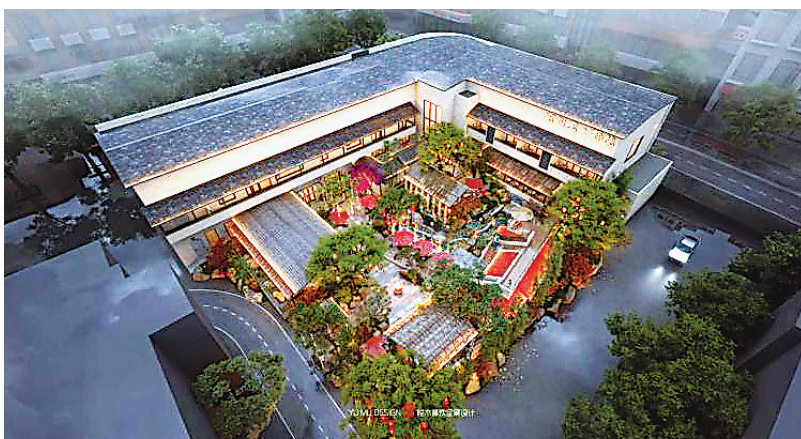
黄陂区武汉第六制药厂老旧厂区更新改造项目。
