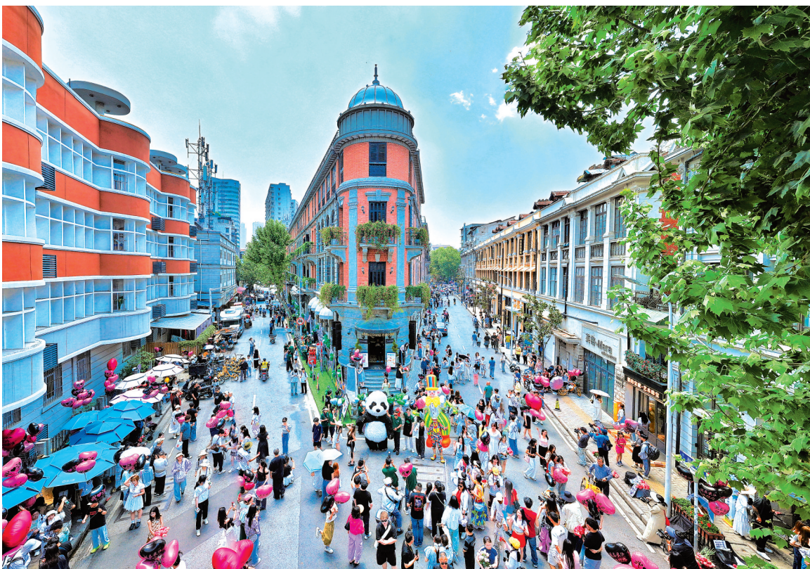
汉口历史风貌区，百年历史建筑巴公房子历经修缮活化工程，变身文旅新地标。
