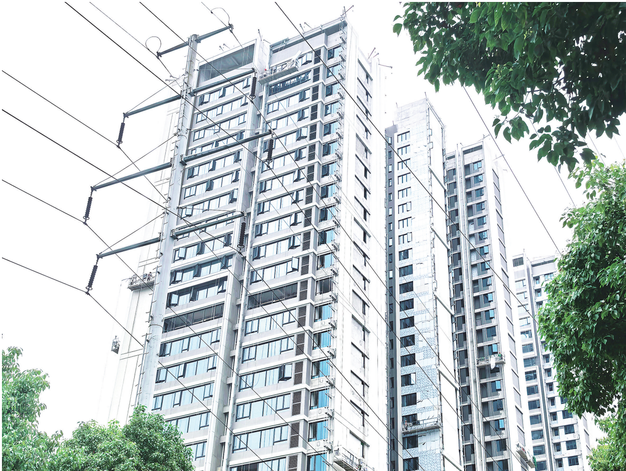
湖北大学危旧改项目施工现场。
