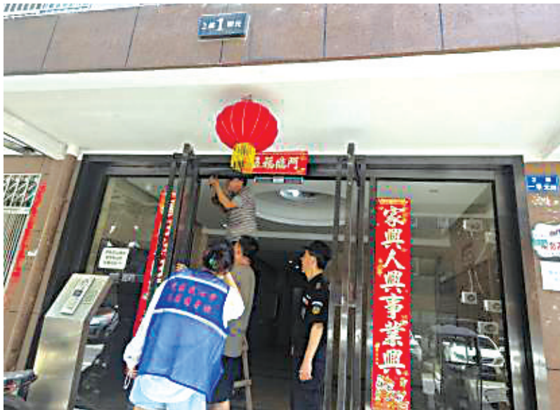
物业工作人员维修单元门。
