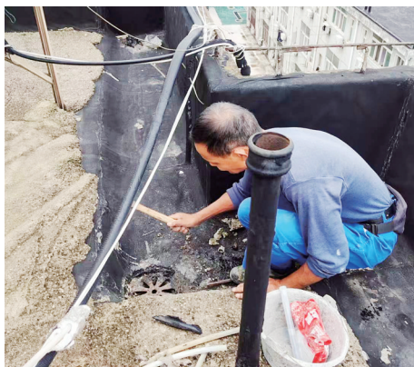
施工单位进行排水管道改造。
