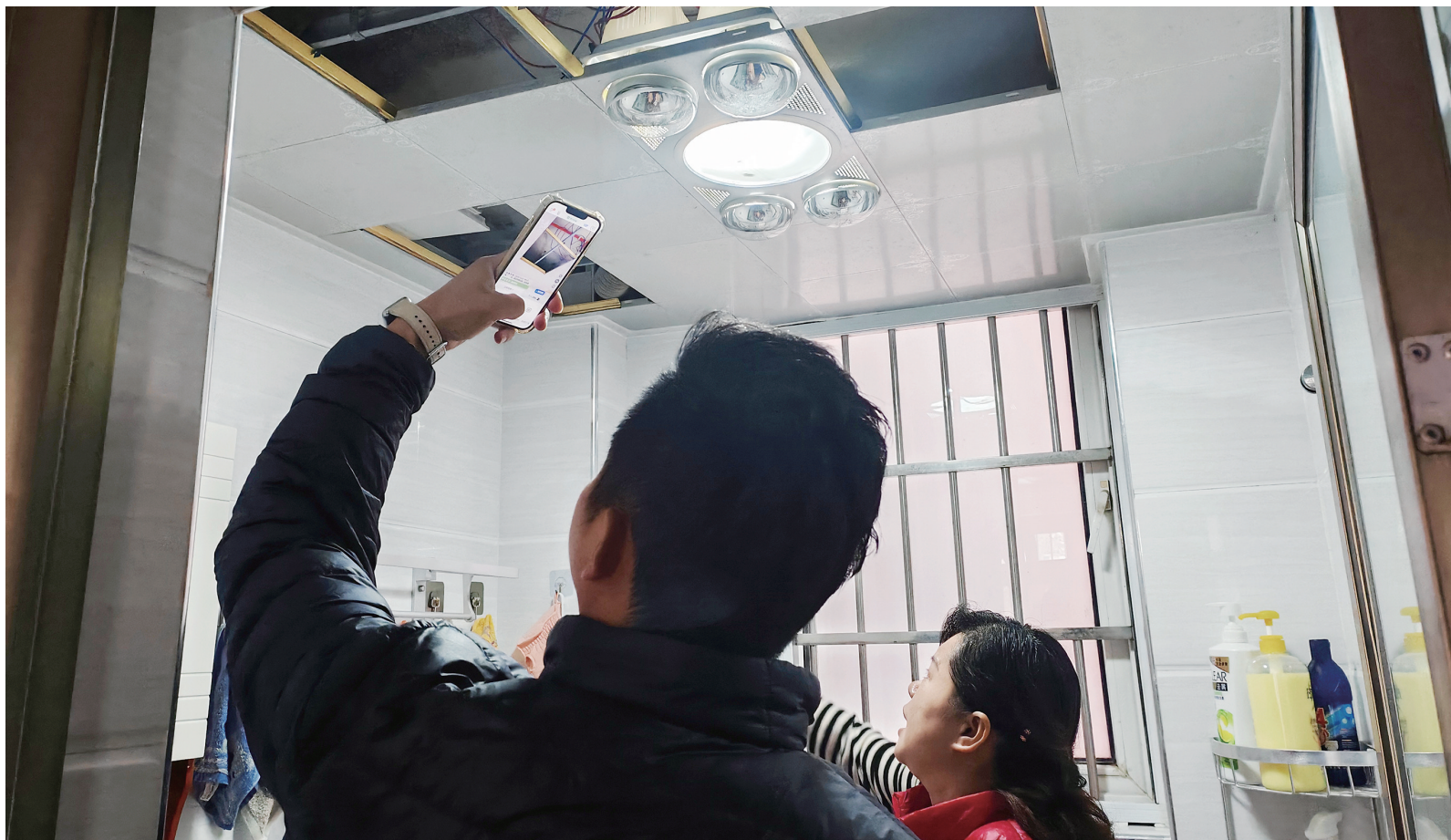
“民生合伙人”上门勘察居民家中损坏的电器。
