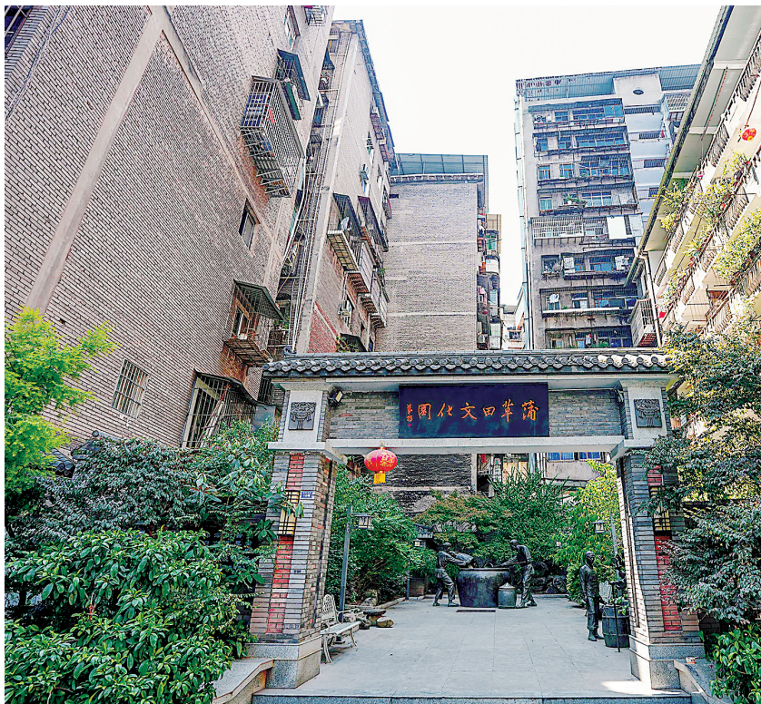
四川达州市小北街社区蒲草田巷改造更新后的景观。
