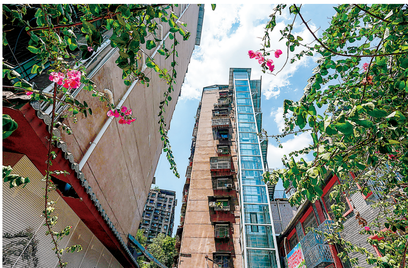
近日,一栋老旧居民楼完成电梯加装。
