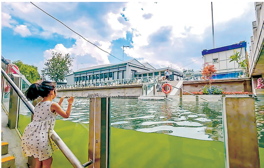
积水潭跨河桥下北护城河边,新添一处能观水看鱼的沉水廊道。
