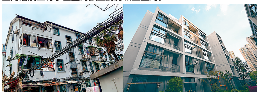
左图是改造前的“小梁薄板”房屋外观(资料照片);右图是改造后的上海黄浦区半淞园路街道市民新村居民区房屋外观。
