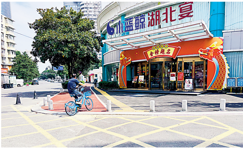
台北路(建设大道—长江日报路)完成人行道改造,路口“零高差”。 记者陶常宁 摄
