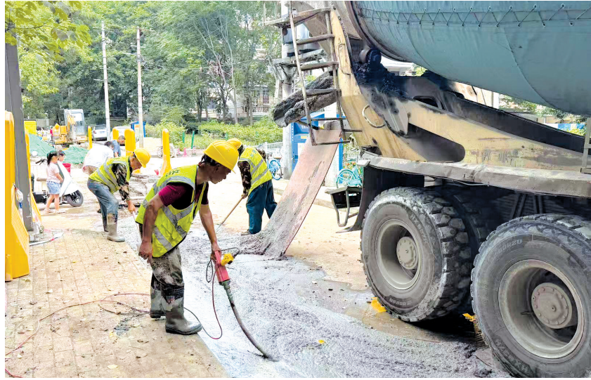
地下管网铺设工作已完成。
