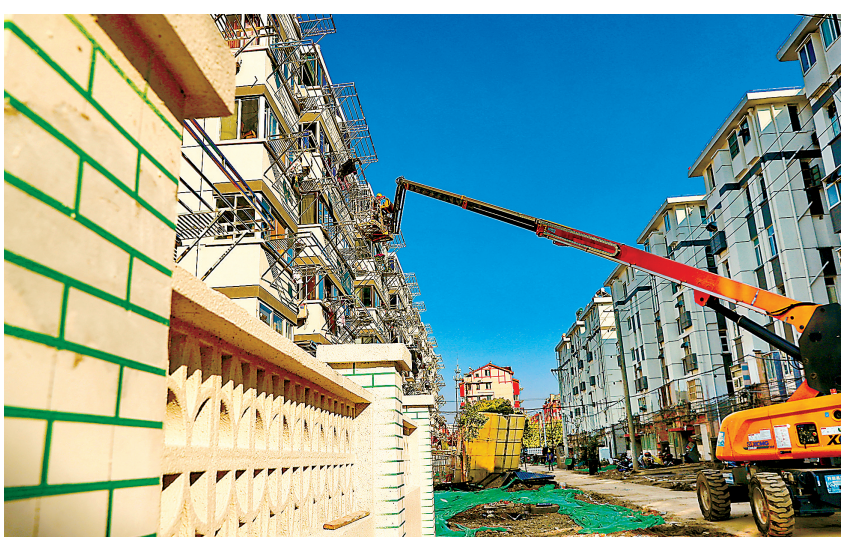
南通市崇川区和平桥街道老旧小区综合改造施工现场。
