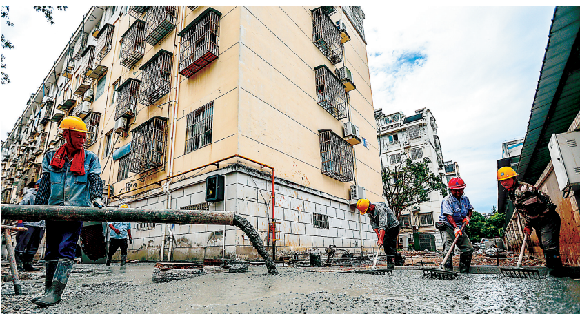
7月8日,湖州市德清县武康街道许园小区改造施工现场。 新华社发
