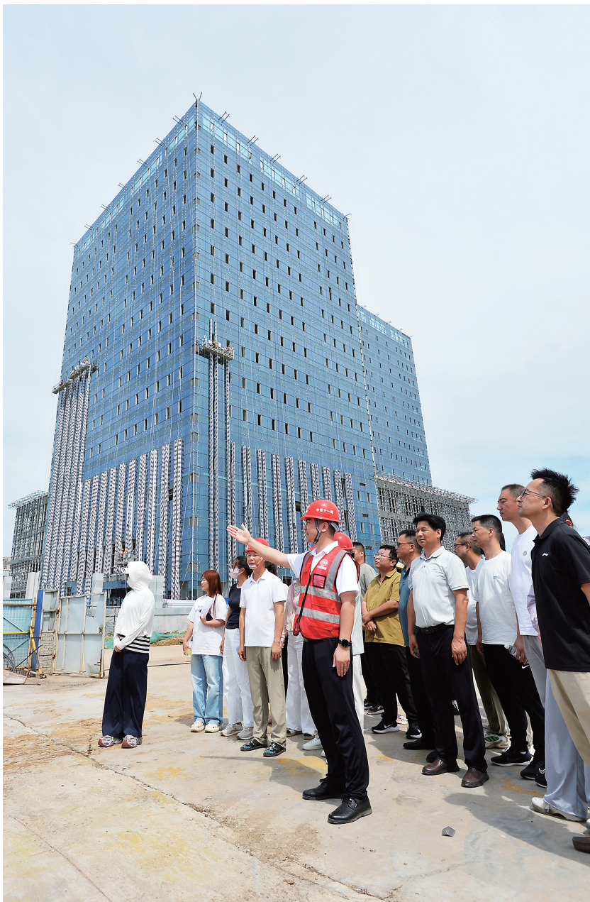
观察团成员在航天新城企业服务中心工地听取施工单位介绍建设情况。
