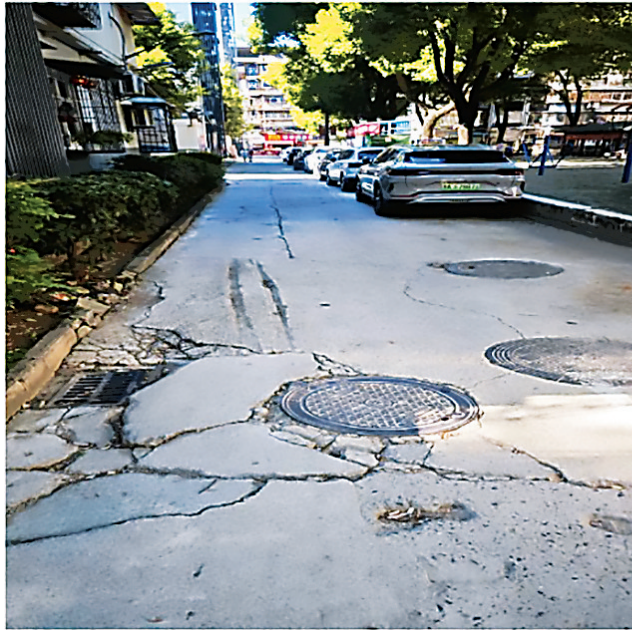
天顺园南社区小区道路刷黑前后照片。
