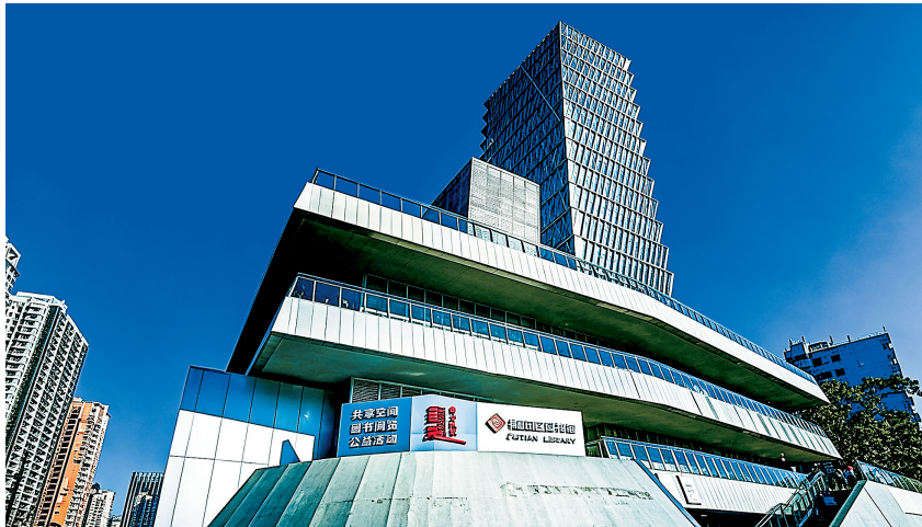
梅园党群服务中心原本是一处封闭闲置的地铁通风塔。
