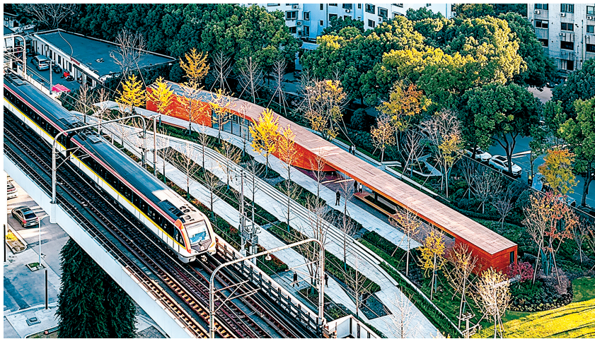
上海徐汇区漕溪花园。
