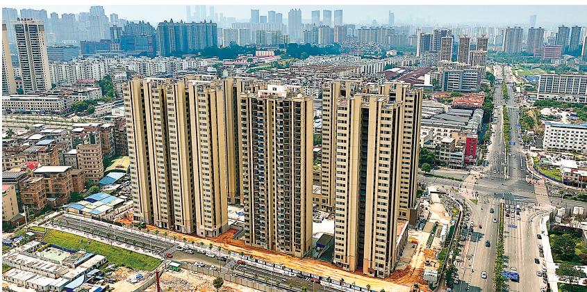
南宁鸡村城中村改造项目建设现场。
