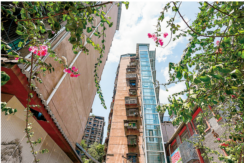
四川达州市一栋老旧居民楼已经完成电梯加装。
