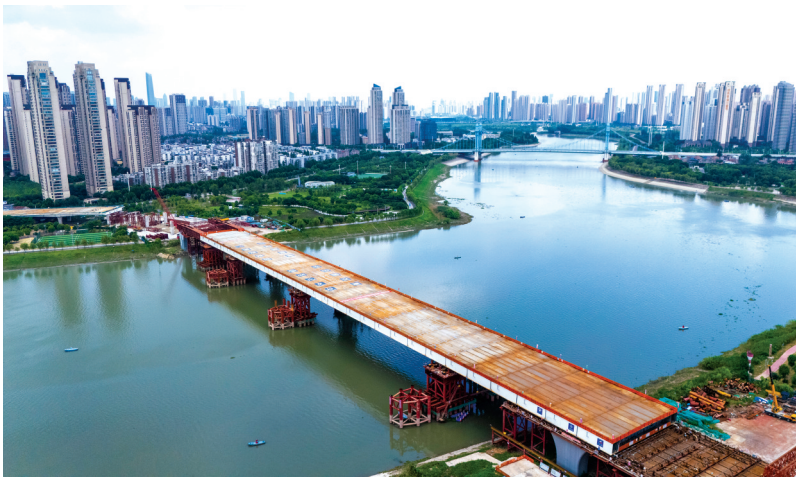
江汉十桥主桥顺利贯通。
