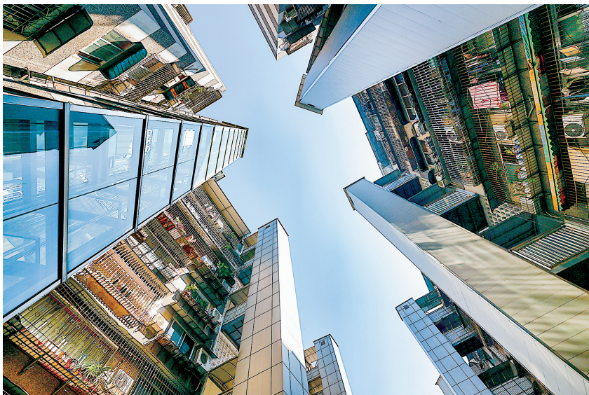
泸州市江阳区大山坪街道一小区完成电梯加装。
