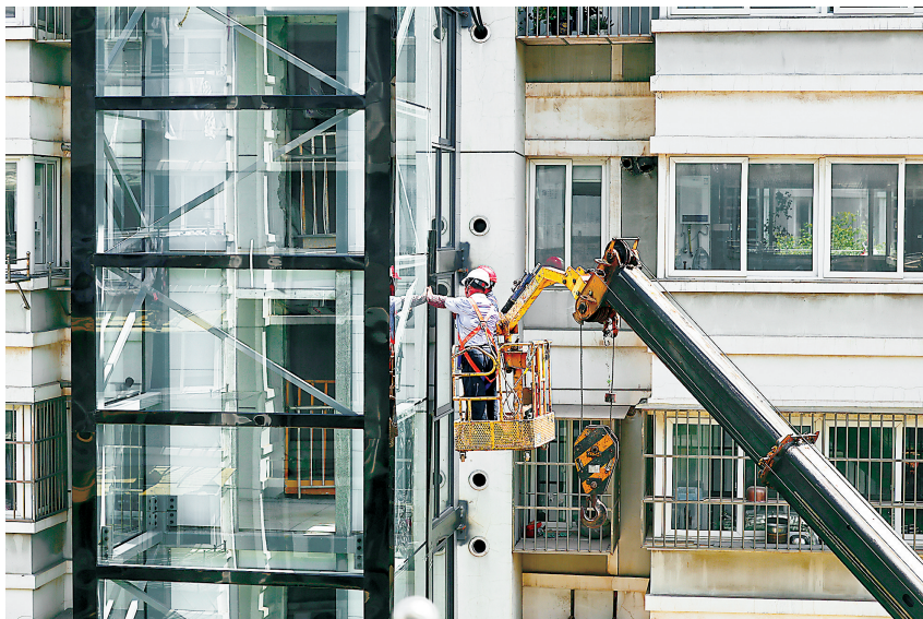
工人在江苏省南通市崇川区文峰街道老小区加装电梯。 新华社发
