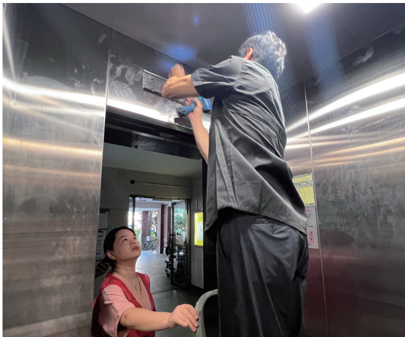
物业安排专业人员进行风幕机安装调试。
