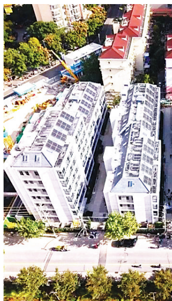
俯瞰原地改造“焕新”的保屯路211弄小区。
