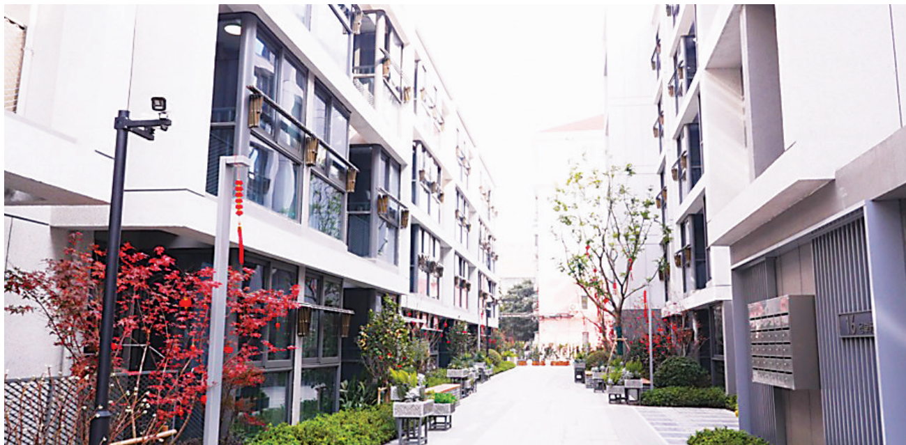
保屯路211弄小区改造后。
