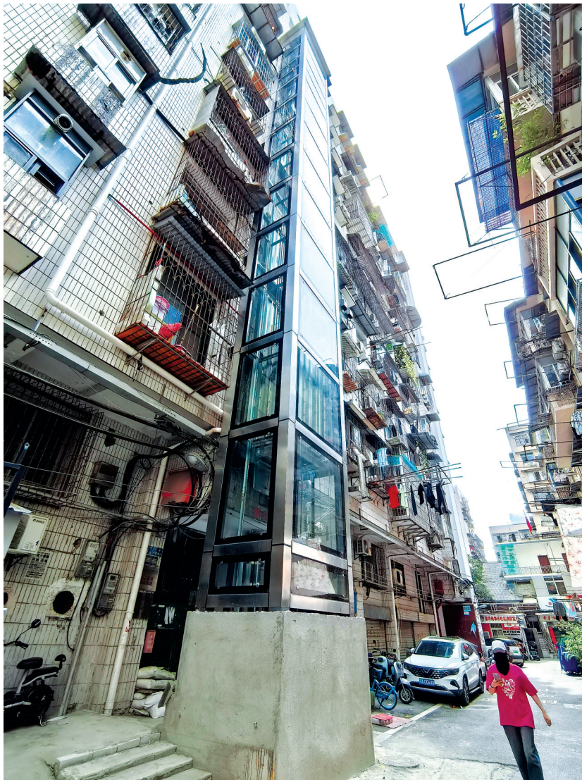
硚口区荣华街道幸乐社区的老旧居民楼加装了电梯。
