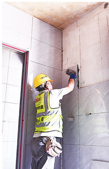
7月27日，建设者在南宁鸡村城中村改造项目建设现场施工。 新华社发
