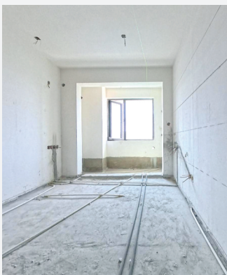
装配式装修施工第一天毛坯原貌。 记者商佩 摄
