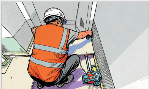
地面模块安装。
