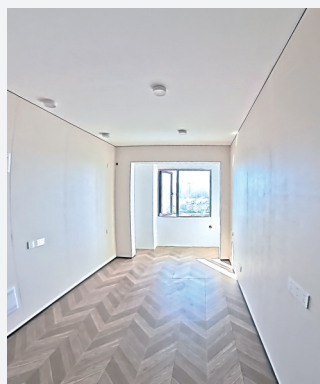
装配式装修完工,平整墙板搭配人字纹地板,空间干净通透、无异味。 记者商佩 摄
