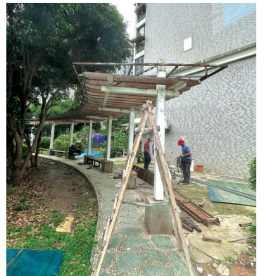
长廊修缮施工中。
