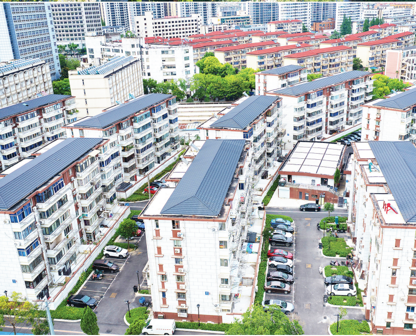
上图为2025年8月28日拍摄的江苏省南通市崇川区虹桥街道虹桥西村老旧小区综合改造施工现场;下图为2026年7月13日拍摄的崇川区虹桥街道虹桥西村老旧小区综合改造新貌。
