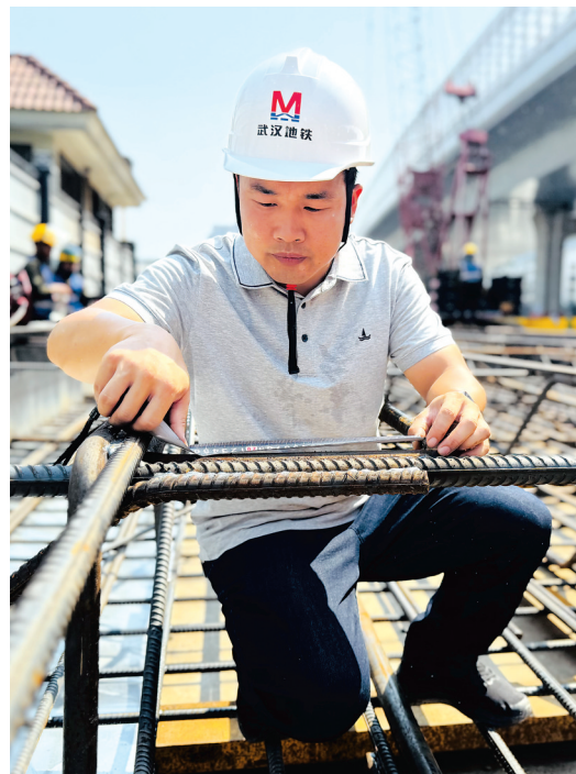
△李超人检查地连墙钢筋笼。
