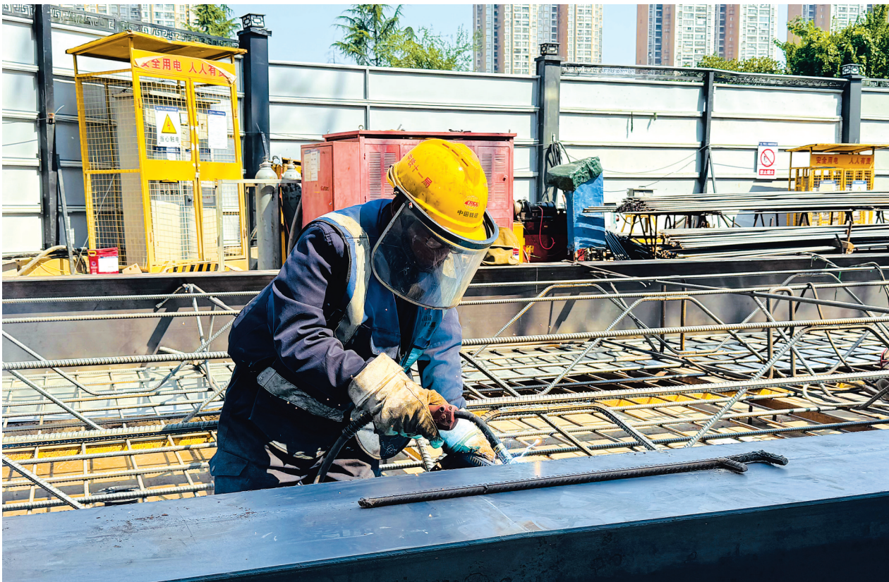
电焊工正在焊接钢筋笼。
