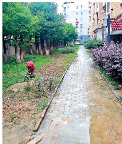
福园小区主路改造前。
