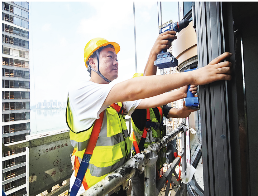
吴科(左)和同事在百米高空安装建筑玻璃窗。
