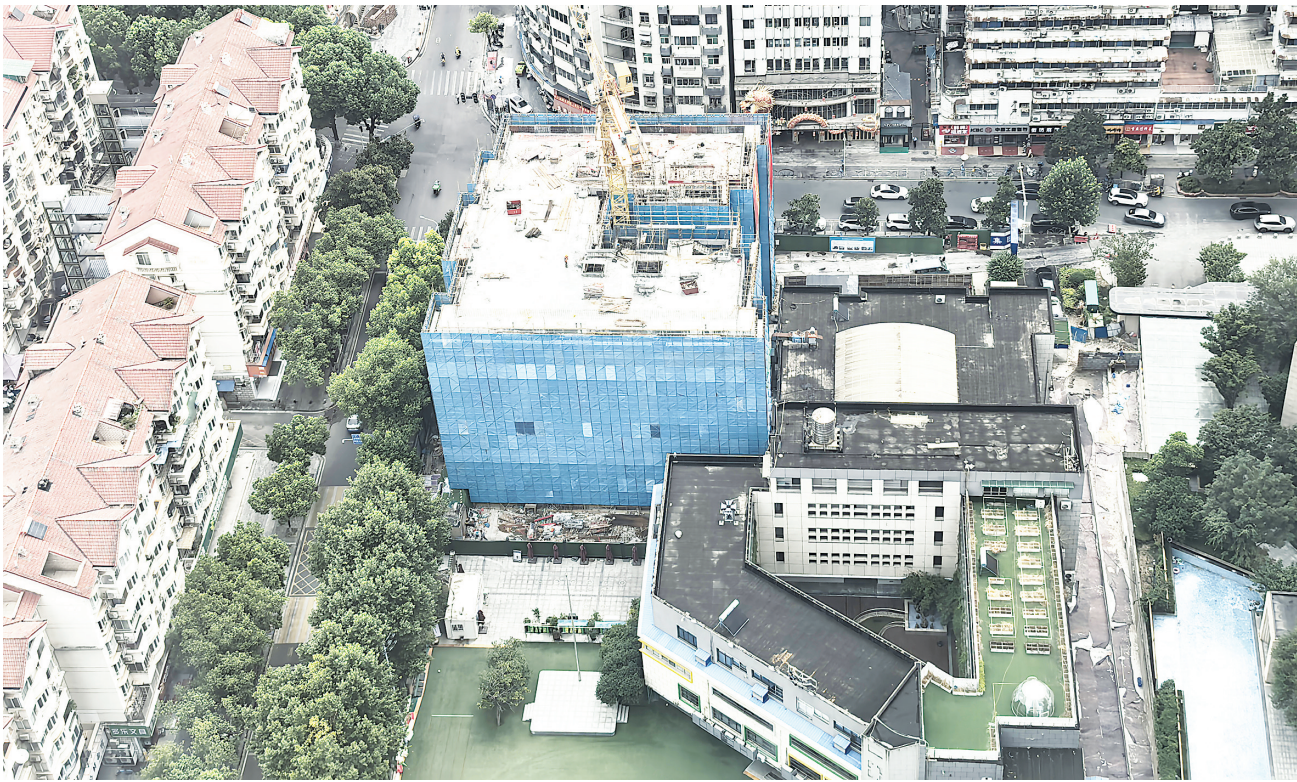
高空俯瞰万松园路251号危房重建项目封顶现场。
