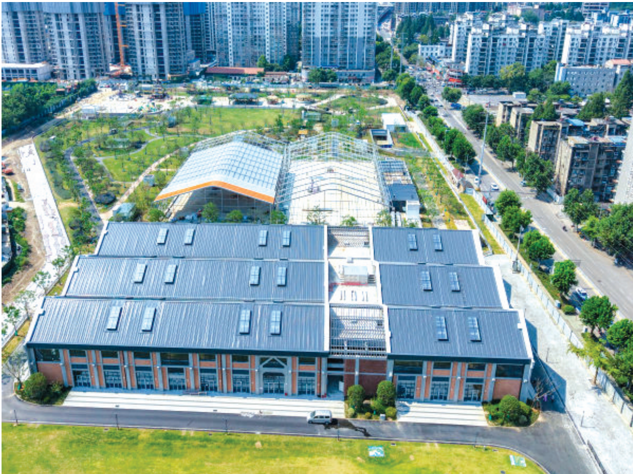
保留下来的老厂房建成室内体育运动空间。
