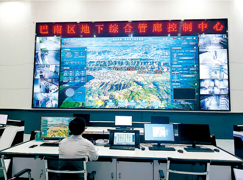
2026年6月16日,在重庆市巴南区地下综合管廊控制中心,工作人员通过综合管廊三维集成与管控系统查看巴南区龙洲湾片区地下综合管廊的环境、结构等监测数据。 新华社发
