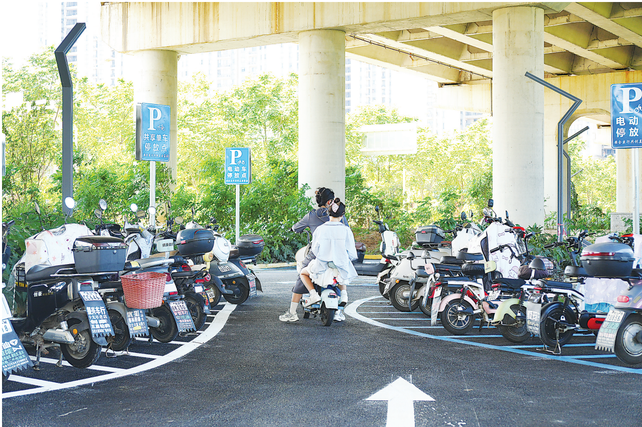
桥下空间变成非机动车停车场,避免车辆日晒雨淋。
