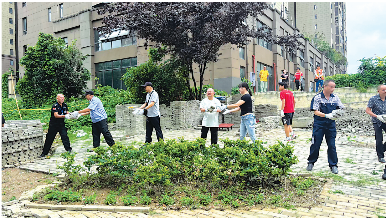
长源社区联合街道综合执法中心规范施工。
