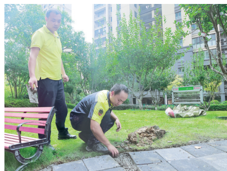
修整小区步道,完善配套设施,提升居民居住舒适度。
