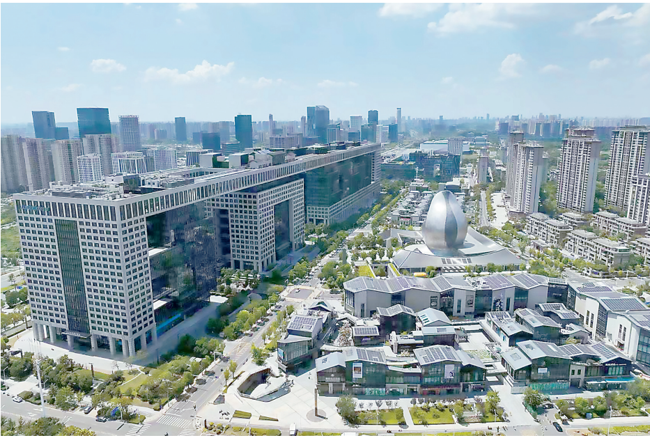
能源站为整个中建科技产业园供冷供热,总供能面积达37.4万平方米。
