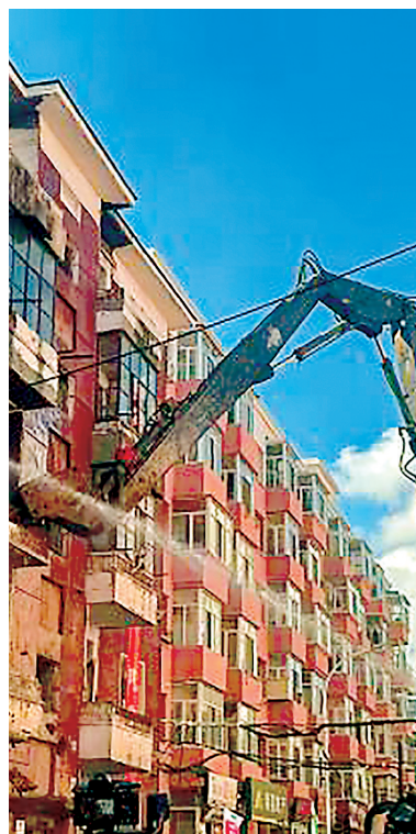
8月14日上午,黑龙江省哈尔滨市南岗区汉阳街52号院内,破碎锤落下第一锤。
