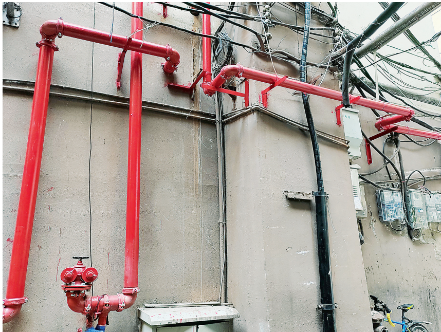
玉三小区消防管道改造后。
