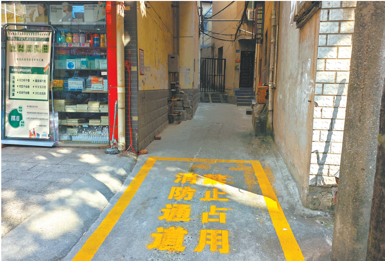
醒目的黄色消防通道标线。
