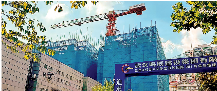
江汉区万松园路251号项目施工现场图。
