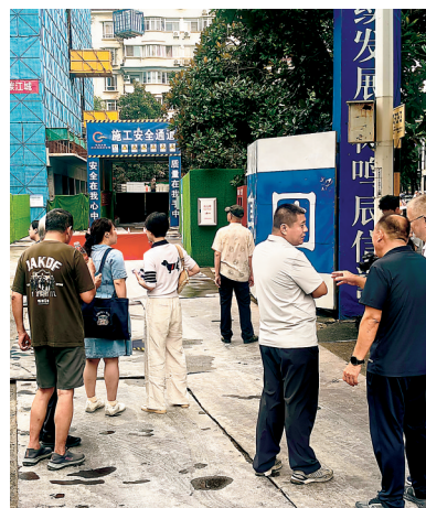
江汉区万松园路251号项目封顶现场,居民与工作人员交流改造相关事宜。
