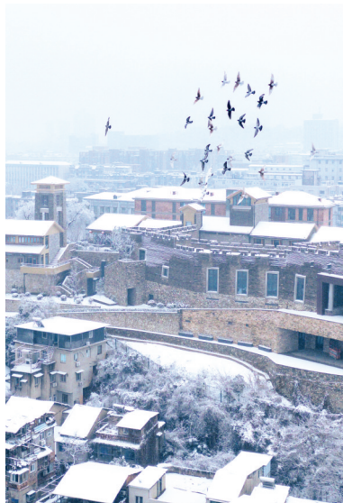
武汉城市更新影像库何海威 摄
