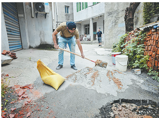
工作人员把挖开的路面用水泥铺新。
